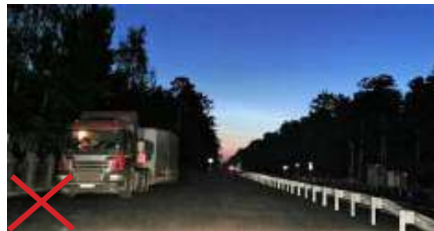
Недопустимо не предусматривать дежурное освещение на объектах ОДС в тёмное время суток.
