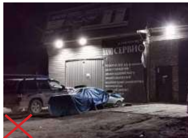
Недопустимо устанавливать светильники (прожекторы) со слепящим эффектом.
